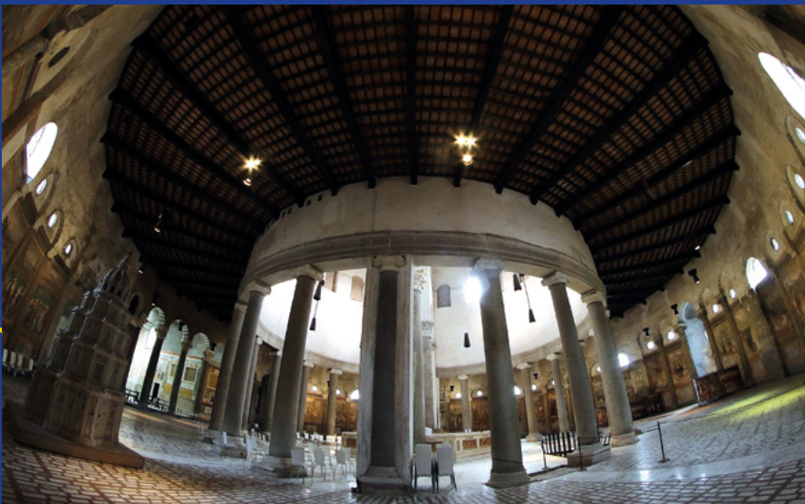
Struttura particolare dell'interno della Basilica di Santo Stefano Rotondo al Celio
